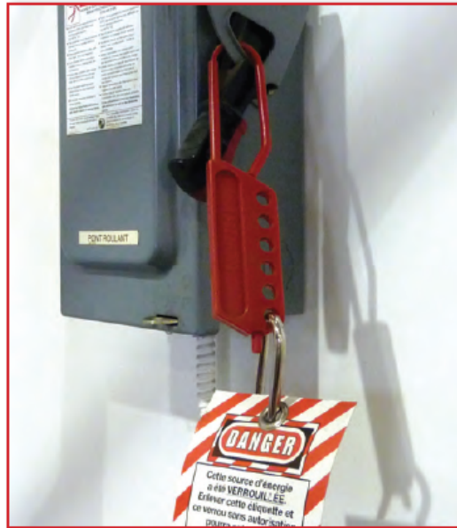
Figure 7 — Point de coupure d'énergie
