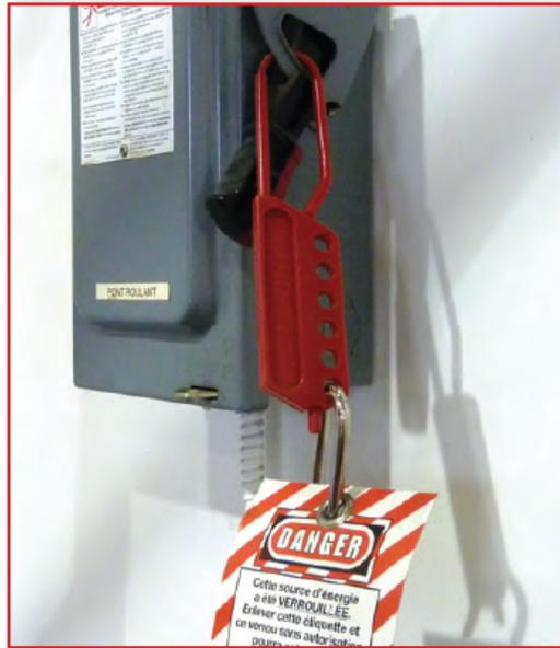
**Figure 7 — Point de coupure d'énergie**
