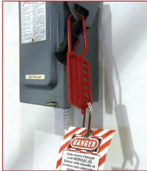
**Figure 7 — Point de coupure d'énergie**
